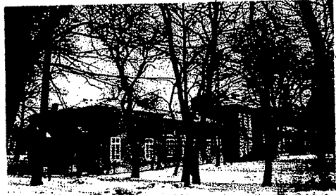
Centralna Biblioteka Lekarska w Warszawie na Jazdowie osuszona w 1996 r.
