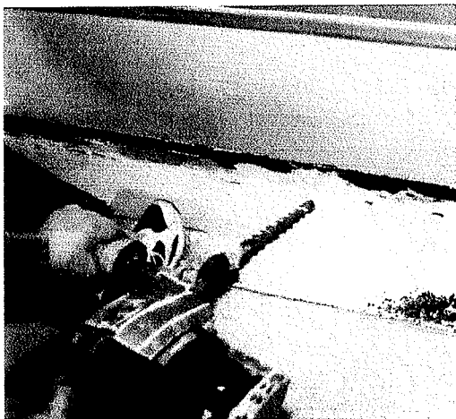
Wiercenie otworów iniekcyjnych
